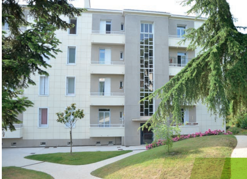
Amélioration des parties communes, salle de bain (douche en lieu et place d'une baignoire, installation d'un sèche-serviettes, cuisine, ...)
