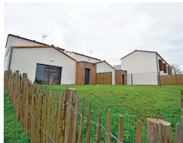
Chavagnes-en-Paillers - Résidence Bellona (10 logements locatifs)
