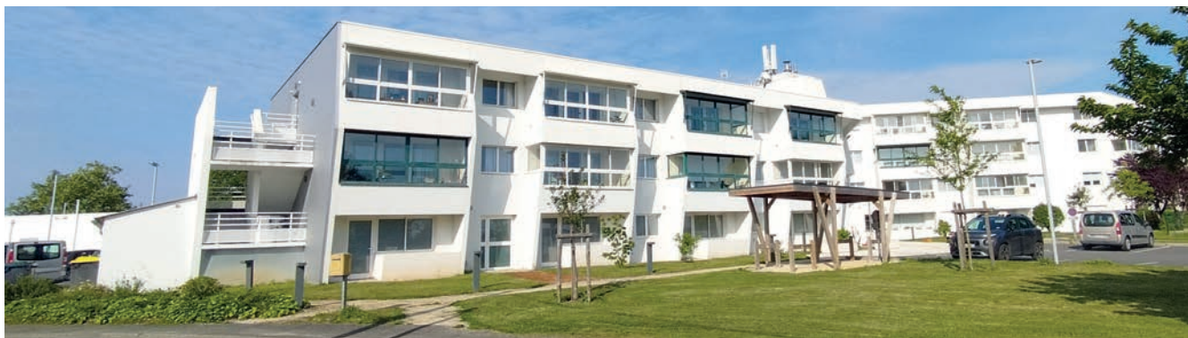
Réhabilitation de l'EHPAD les Pictons à Chaillé-les-Marais
