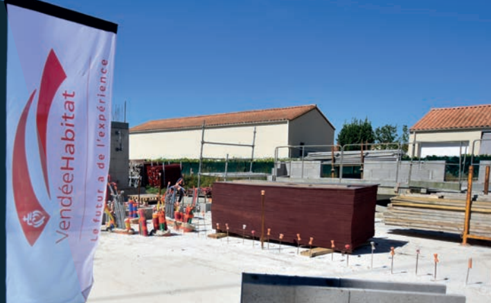
Travaux d'une résidence intergénérationnelle de 21 logements à Bellevigny
