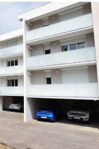
Fontenay- le -Comte - Réhabilitation des 28 logements de la Résidence Le Coq Hardy
