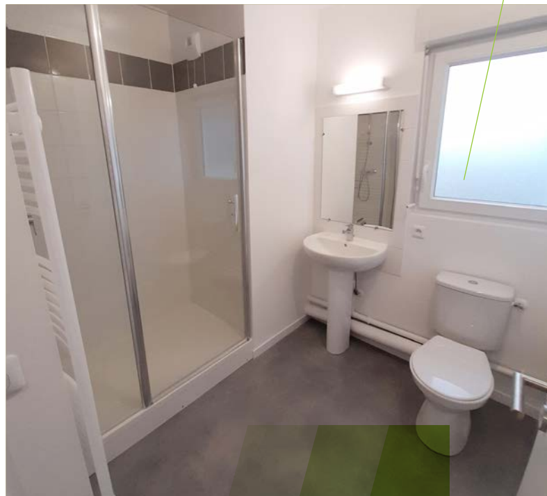
Salle de bain après travaux (douche en lieu et place d'une baignoire, installation d'un sèche serviette, nouveau sol, ...)
