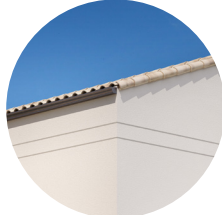
Jeux d'enduits possibles (enduit peint, joints creux, ...)
