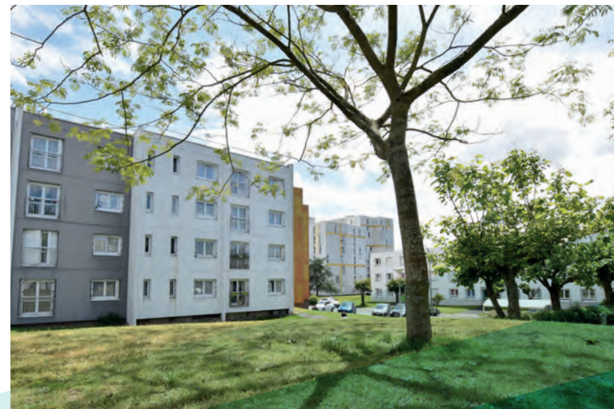
Résidence la Vigne-aux-Roses à la Roche-sur-Yon
