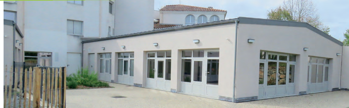
EHADP La Source à Beaulieu-sous-la-Roche
