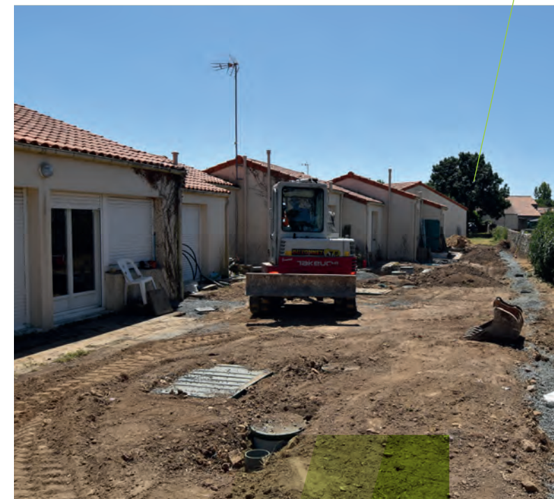
Puyravault - Réfection des assainissements autonomes
