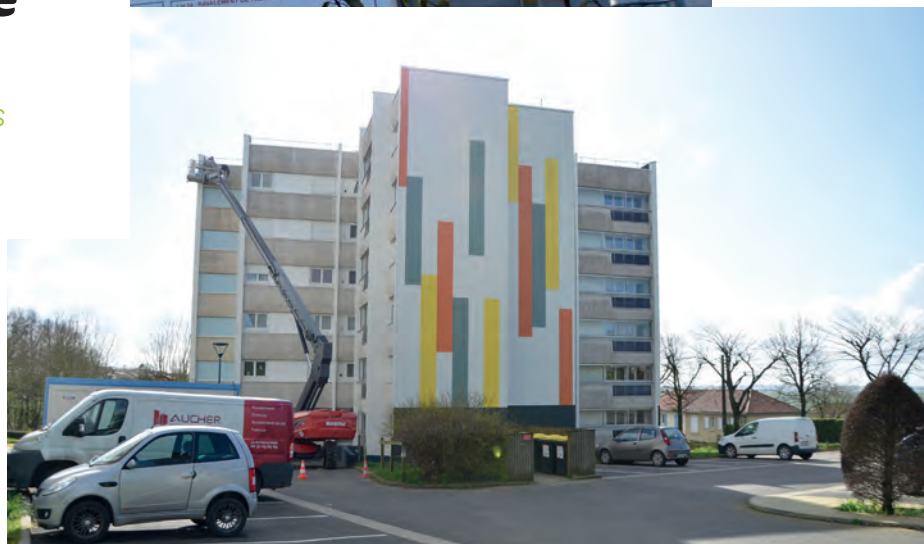
Réhabilitation de la résidence Saint-Christophe-du-Bois à la Châtaigneraie
