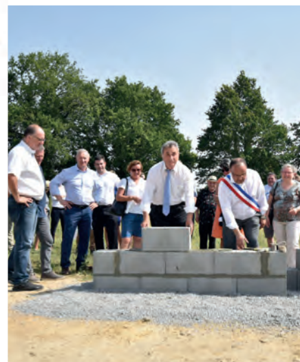
Pose de la première pierre de 24 logements locatifs, zone de la Grimoire à Mouilleron-le-Captif
