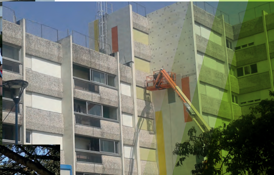
La Châtaigneraie - Réfection de façades
