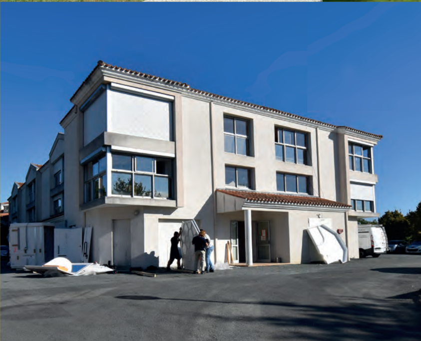
Beaulieu-sous-La Roche - Réhabilitation de l'EHPAD La Source
