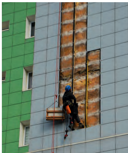
La Roche-sur-Yon - Réfection de l'isolation par l'extérieur
