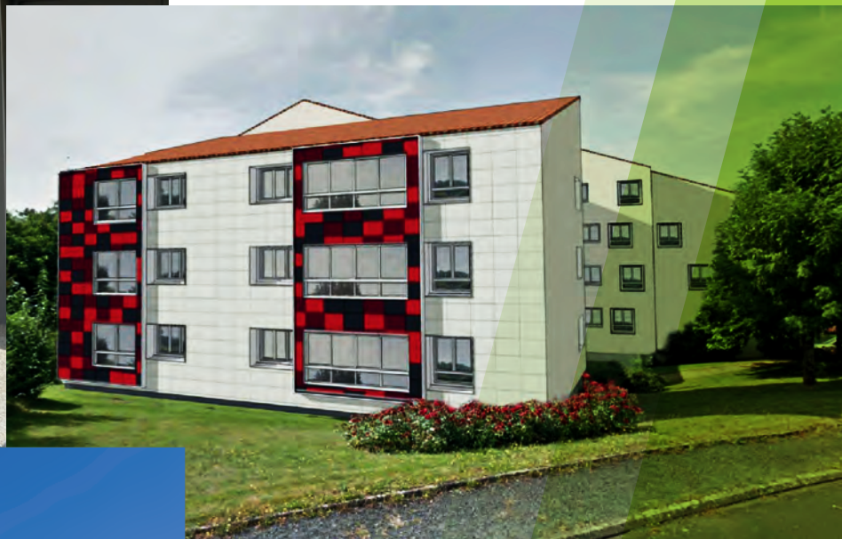
La Châtaigneraie - Réhabilitation de la résidence La Chapotière
