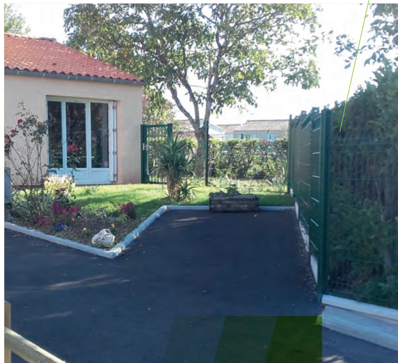
Benet - Réfection des clôtures de la résidence Le Champ du Bois
