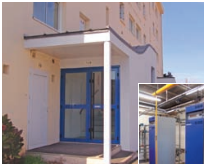
Nouvelle chaufferie Résidence Les Fontennes
