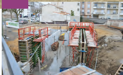
QUOI DE NEUF Construction de 104 logements à la Roche-sur-Yon P. 2
