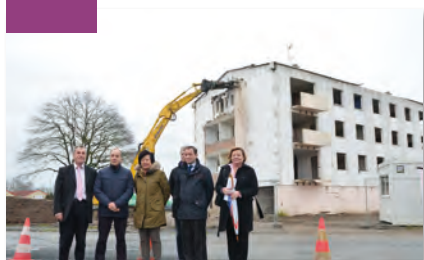
QUOI DE NEUF Déconstruction de la résidence le Chaintreau à Mortagne-sur-Sèvre P.2
