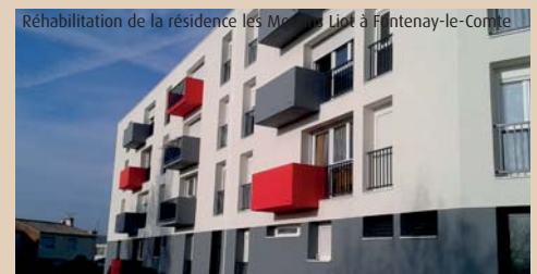
Réhabilitation de la résidence les Moutons à Fontenay-le-Comte
