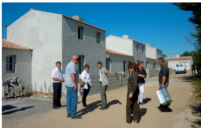
Résidence Les Bébés Gris (construction en cours) — L'Île d'Yeu
